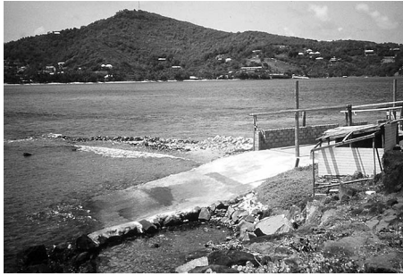
写真3 基礎部分のみが完成した鯨類解体処理施設（センプル・ケイ）
